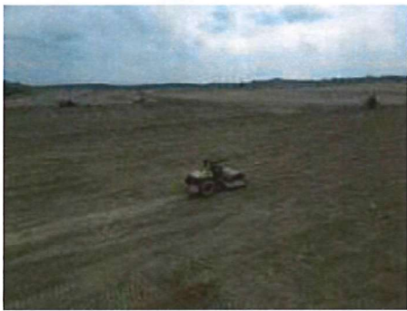
ภาพที่ 3 การบดอัดดิน
